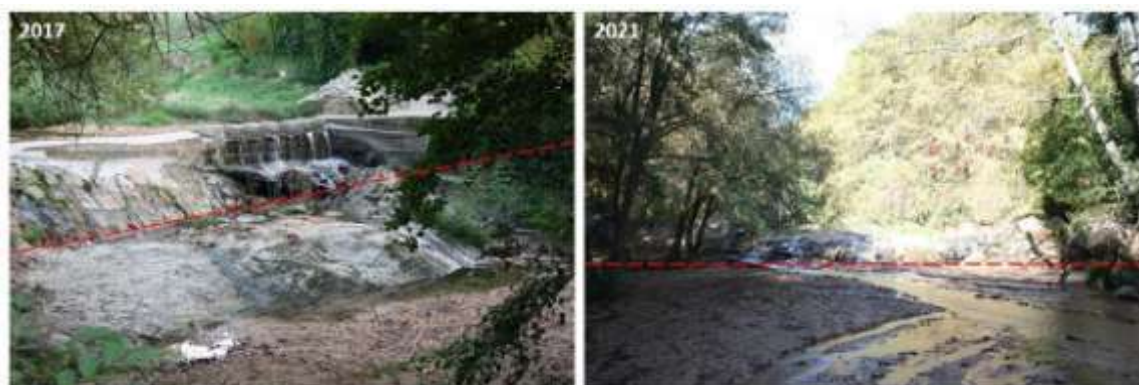
Figura A10. Comparativa d'una fotografia de la resclosa de Sant Salvador de l'any 2017 amb un altre de l'any 2021 (actual) que confirmen els resultats obtinguts amb el GIS (entre 20 y 55 cm d'acumulació).
